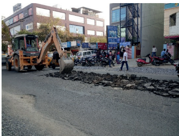
Rys. 1. a) Usuwanie starej nawierzchni, b) Składowisko ZNA
